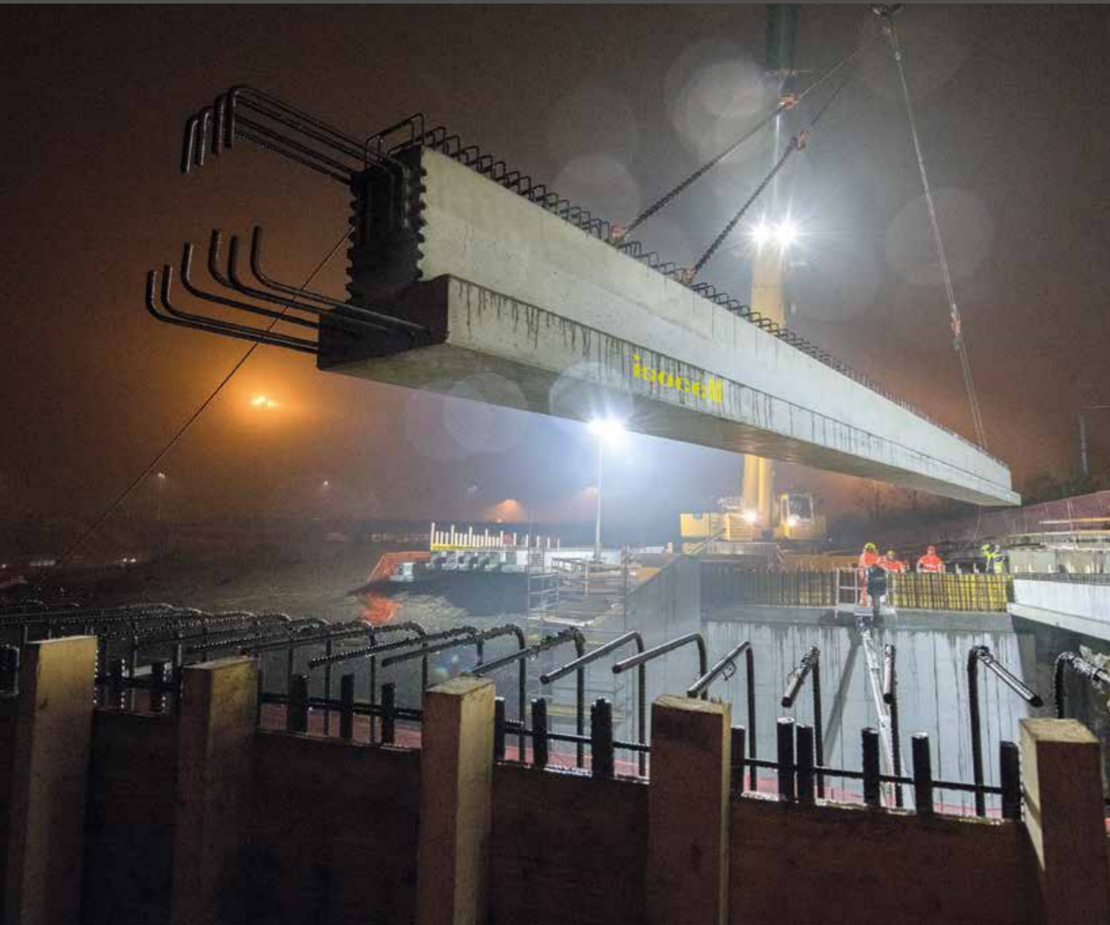
2023 SVINCOLO AUTOSTRADALE BERGAMO A4
