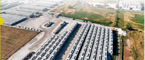
STABILIMENTO PRODUTTIVO ISOCELL ALTA VELOCITÀ NAPOLI BARI
