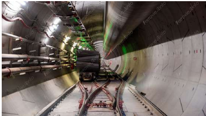
Da Hinterrigger alla Galleria di Base del Brennero
