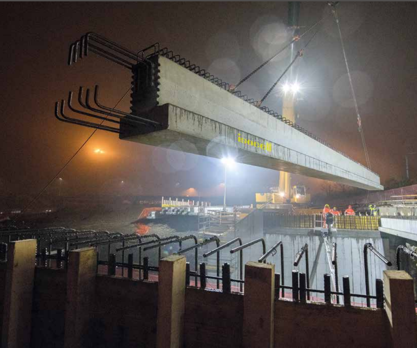
2023 SVINCOLO AUTOSTRADALE BERGAMO A4
